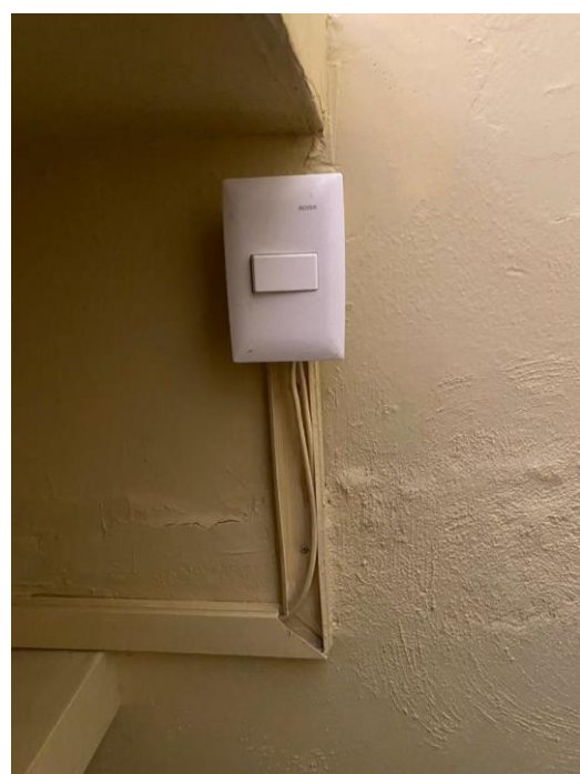
Figura 34. Instalación de luz.
