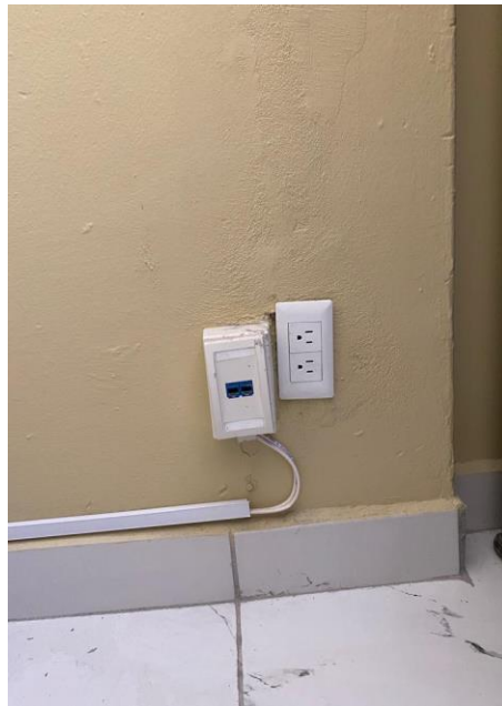
Figura 32. Instalación de luz.
