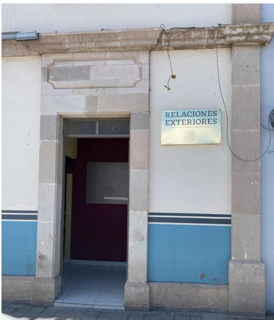
Figura 29. Fachada de la oficina.
