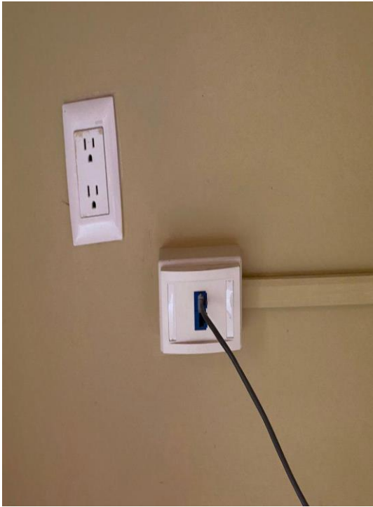
Figura 35. Instalación de luz.
