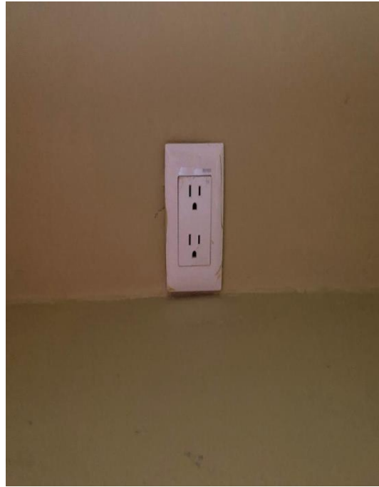
Figura 36. Instalación de luz.
