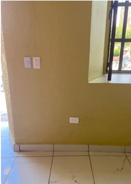
Figura 31. Instalación de luz.
